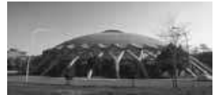
FIGURA 9-34 Ejemplo 9-13. a) El domo del Pequeño Palacio Deportivo en Roma, construido para los Juegos Olímpicos de 1960. b) Componentes de fuerza que cada contrafuerte ejerce sobre el domo.
