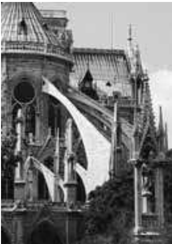
FIGURA 9-30 Contrafuertes volados en la catedral de Notre Dame, en París.
