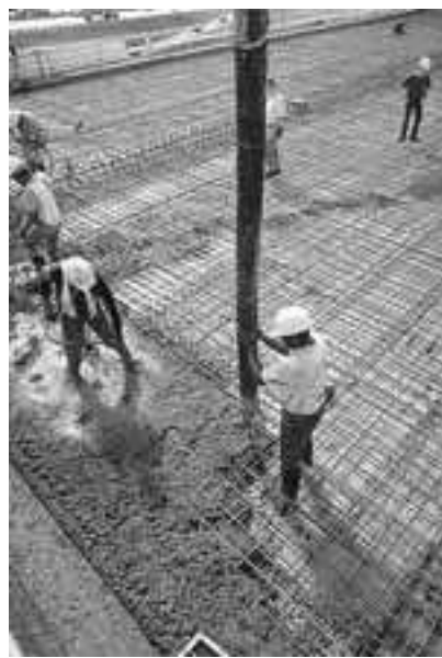
FIGURA 9-26 Varillas de acero alrededor de las cuales se vierte concreto para formar una nueva autopista.
