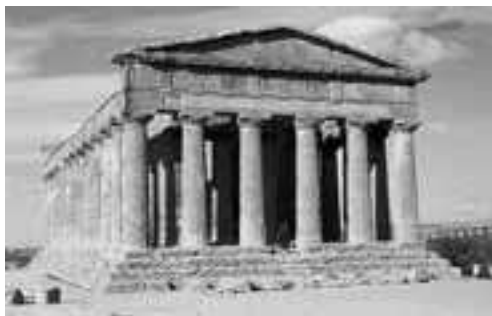
FIGURA 9-21 Este templo griego, en Agrigento, Sicilia, erigido hace 2500 años, es un ejemplo de construcción con postes y vigas. Las columnas están bajo compresión.
