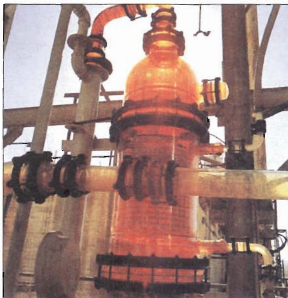
FIGURA 4.17 Manufactura industrial de bromo líquido mediante la oxidación, con cloro gaseoso, de una disolución acuosa que contiene iones \text{Br}^- .
